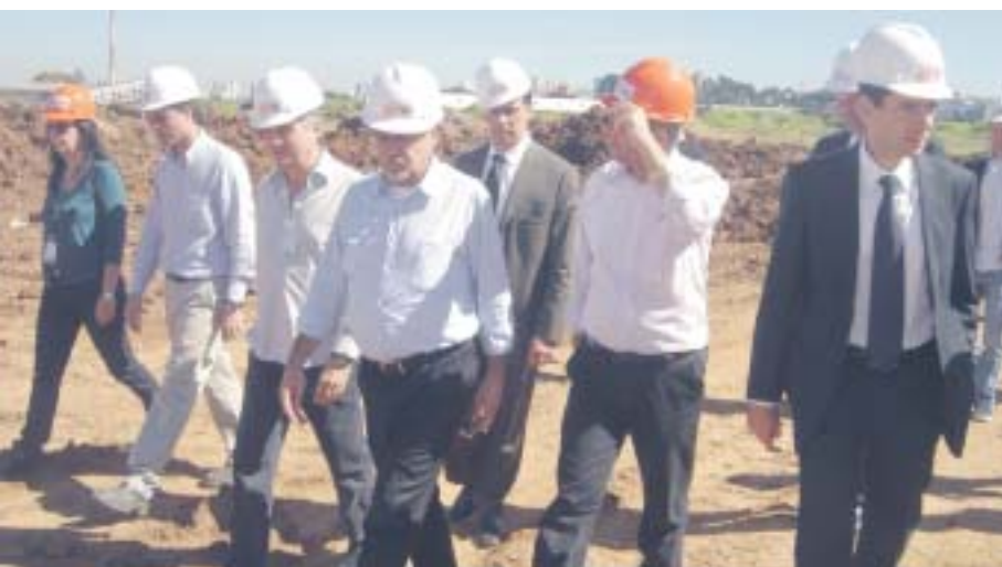
Prefeito e técnicos visitam canteiro de obras da ETE Várzea do Palácio
